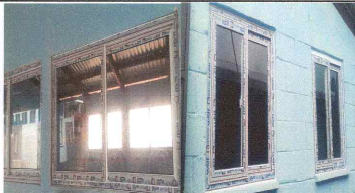
Foto: 2 Sustitución de estructuras estructuras de metal de ventanas
