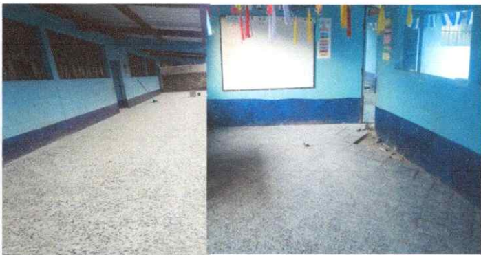
Foto 4: Sustitución de piso de torta de cemento por piso de mosaico de granito
