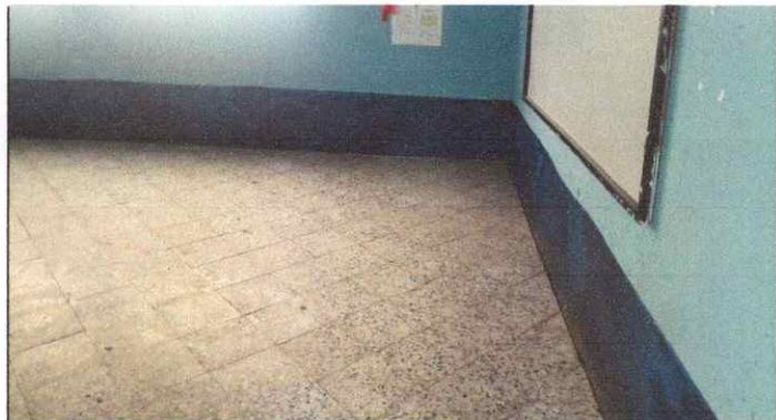
Foto 4: LOSA DE PATIO: Sustitución de piso de torta de cemento por piso de mosaico de granito
