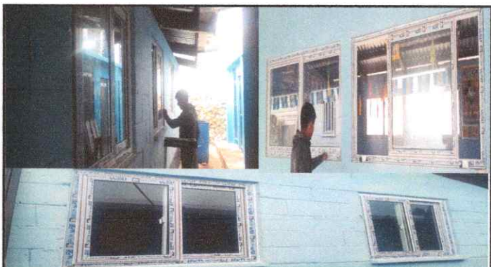
Foto 4: LOSA DE PATIO: Sustitución de estructura de metal de ventanas
