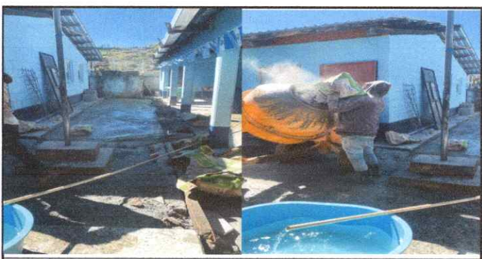
Foto 6 Reparación de plancha de torta de concreto de patio recepción de cemento
