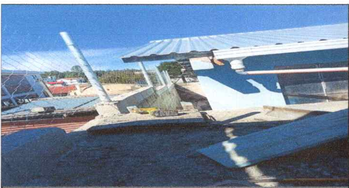
Foto 5: Sustitución de tubo hg y malla galvanizada
