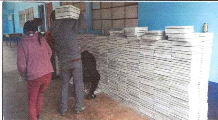
Foto: 2 Recepción piso de mosaico de granito
