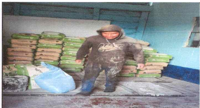
Foto 4: Recepción de cemento
