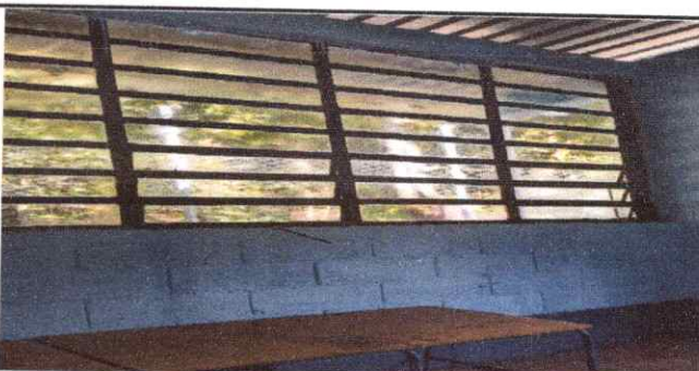
Foto No. 6: Pintura y vidrios de ventana nuevas
