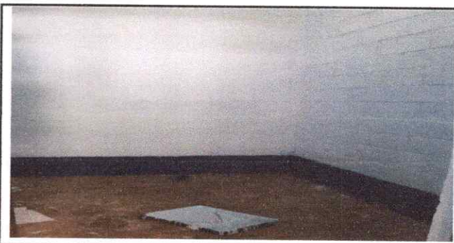
Foto No. 6: Pintura en paredes
