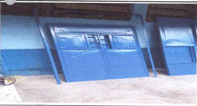
Foto No. 5: Reparación de puertas
