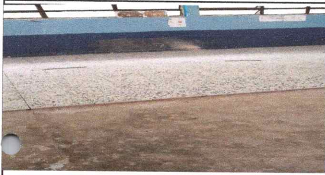
Foto No. 1: Cubierta de ceramica en el piso
