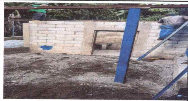
Foto No. 4: Cambio de techo de cocina
