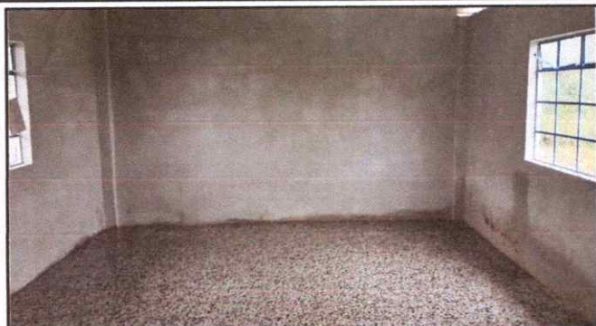
Foto1: Colocación de piso de granito
