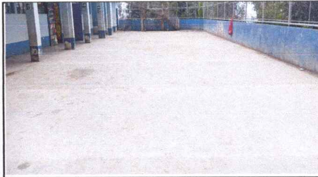
Foto 4: Piso de patio ya elaborado
