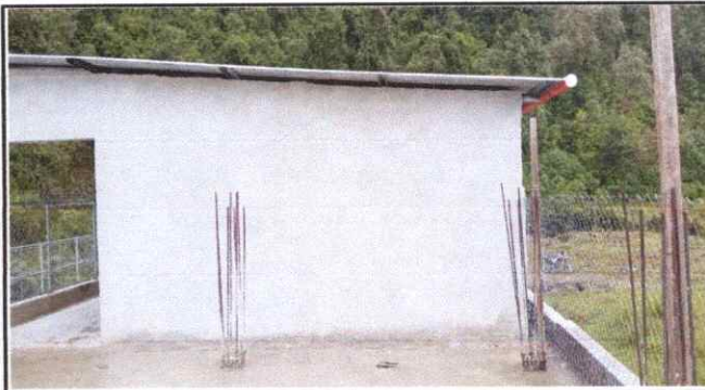
Foto 2: Canal de bajada de agua instalado
