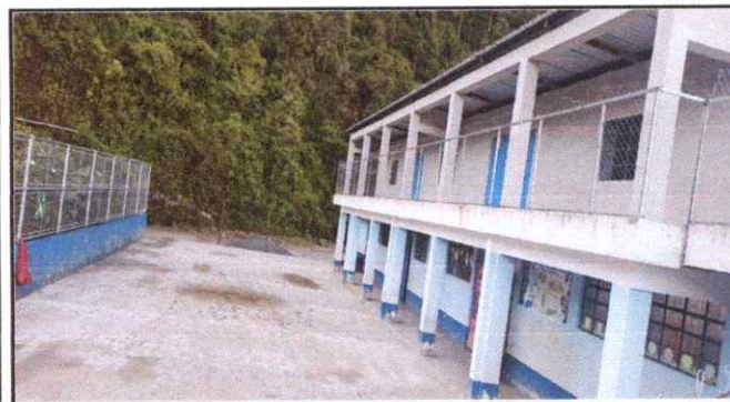
Foto 3: barandas ya instaladas
