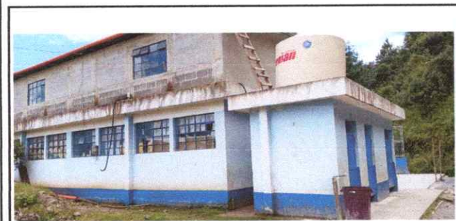
Foto 5: Deposito de agua ya instalado
