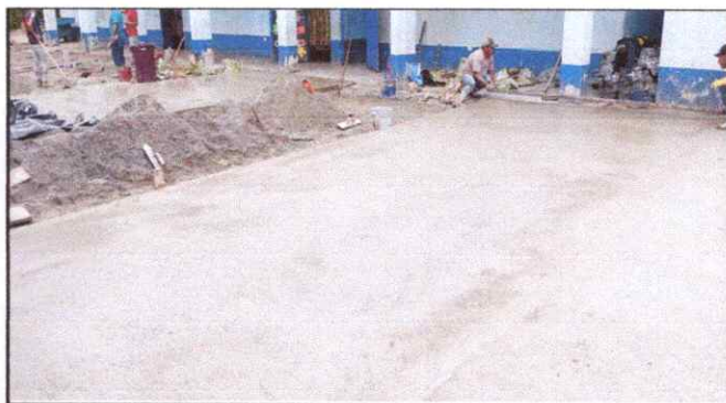
Foto 4: Realizando planchas de concreto
