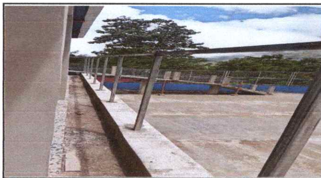
Foto 3: Cambio de estructura de baranda
