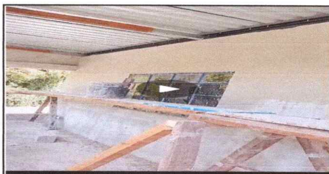
Foto 6: Repello de paredes externos
