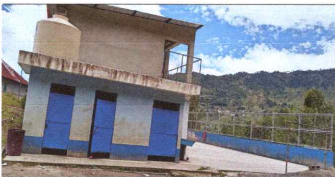
Foto 5: Deposito de agua en proceso de instalación
