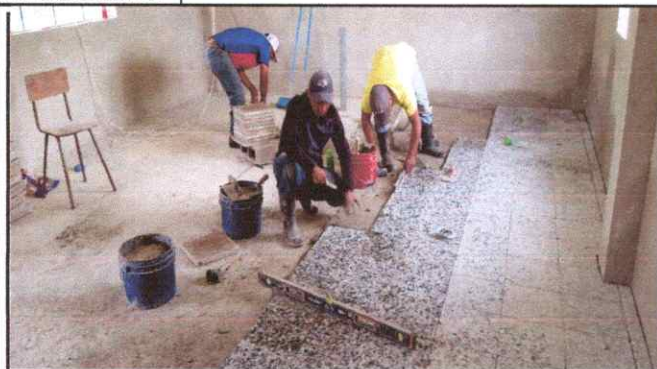
Foto1: Colocación de piso de granito
