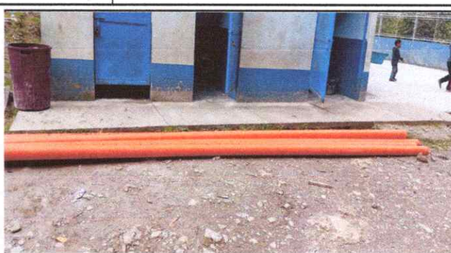
Foto 2: Ya con los materiales para su instalación
