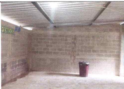
Foto 5: Deposito de agua inadecuado
