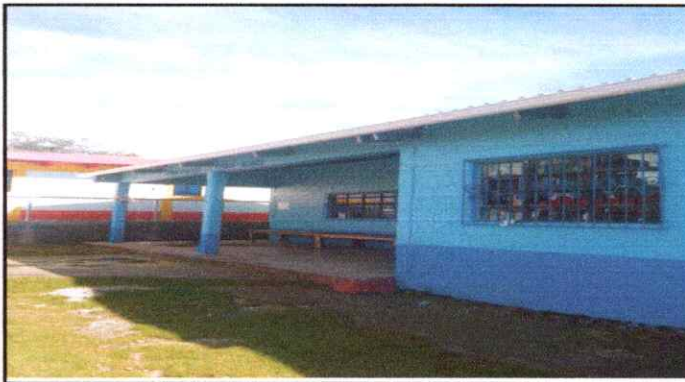
Foto 2: Techo y canales de pvc instalados.
