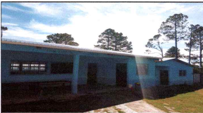
Foto 4: Techo de escuela terminado.
