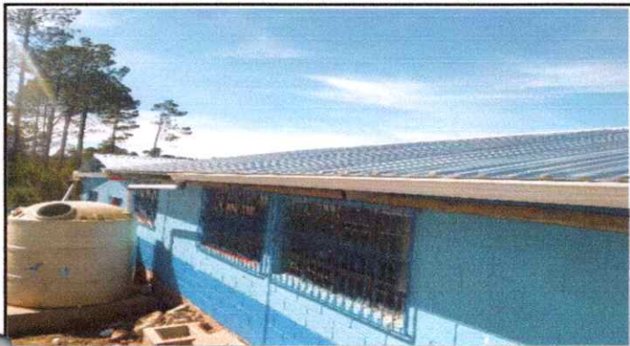
Foto 1: Lámina troquelada calibre 26 instalada correctamente.
