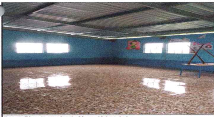
Foto 5: Piso de granito de 30 por 30 instalado.
