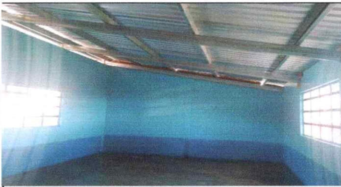
Foto 3: Costaneras y vigas de metal instaladas.
