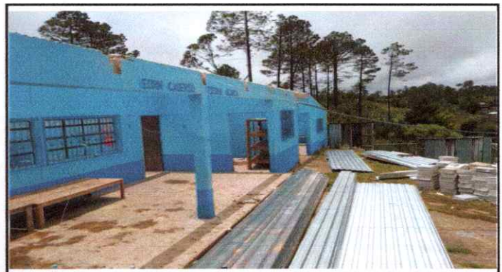
Foto 4: Preparando las costaneras de metal para su instalación.
