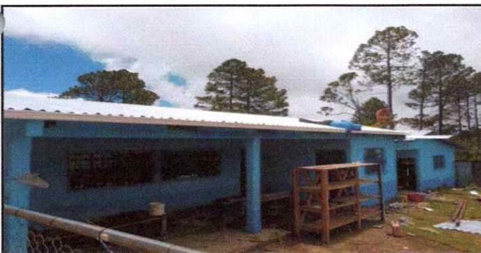
Foto 5: Instalando canaletas de pvc para agua pluvial.
