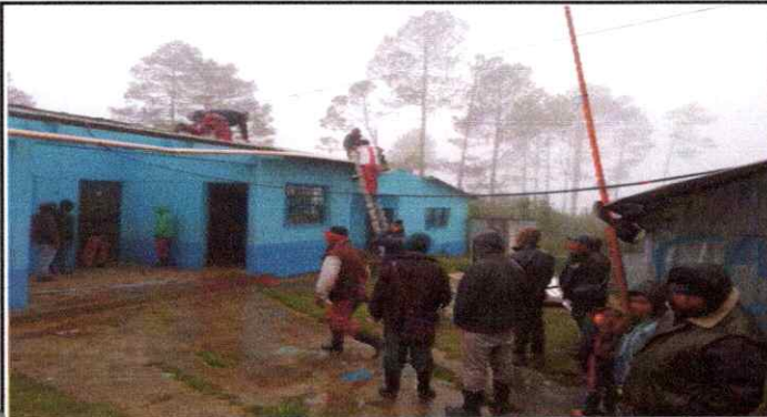
Foto1: Desinstalando techo de la Escuela.
