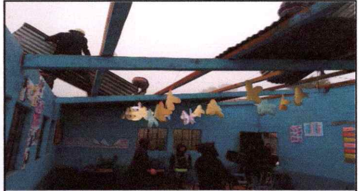
Foto 2: Desinstalando costaneras y vigas de madera.
