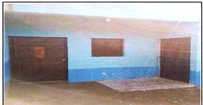
Foto 6: Instalando los ultimos metros de piso de granito e instalando puertas.
