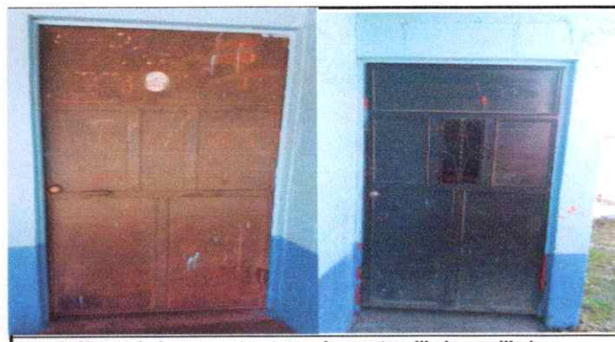
Foto 6: Mantenimiento a estructuras de puertas, lijado, cepillado, sujeción y aplicación de pintura.
