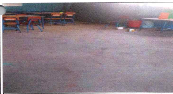
Foto 5: Sustitución de de piso de torta de cemento por piso de granito.
