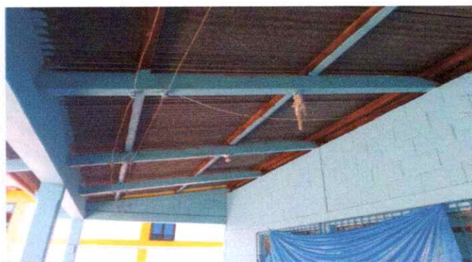
Foto 4: Sustitución de costaneras de madera por metal.
