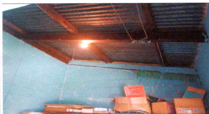
Foto 3: Sustitución de costaneras de madera por metal 2*6
