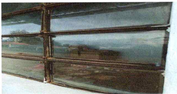
Foto 5: Sustitución de vidrios
