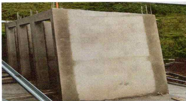
Foto 9: Repello en muro
