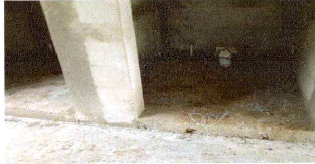
Foto 12: Sustitución de tubería línea principal aguas negras
