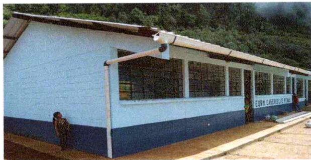
Foto 11: Pintura en muros exteriores e interiores
