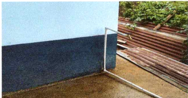
Foto 13: Sustitución de tubería línea principal.
