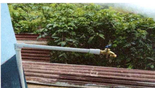
16. Sustitución de Grifo
