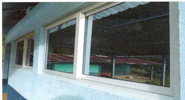
Foto 4: Sustitución de ventanas de madera por PVC mas vidrio
