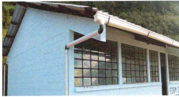
Foto 10: Sustitución de canal de metal por pvc
