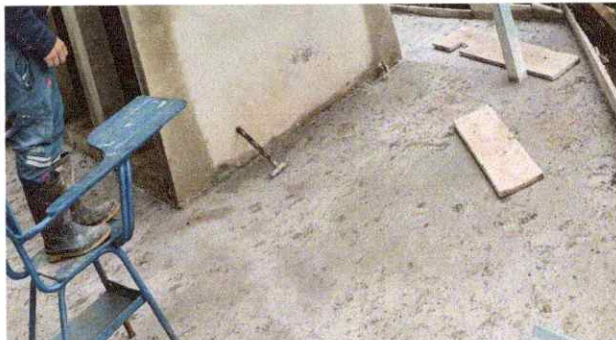
Foto 7: Sustitución de piso de torta de concreto
