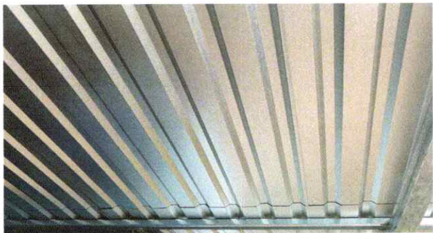
Foto1: Sustitución de lámina, por lamina troquela aluzinc calibre 26
