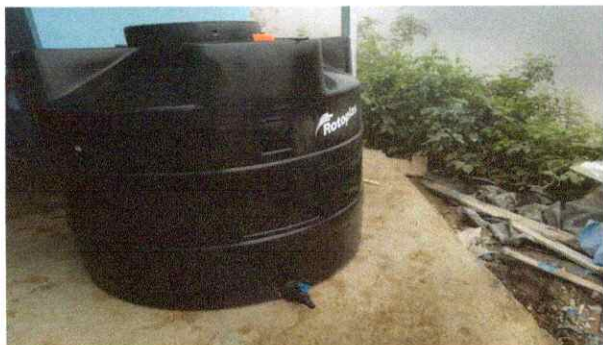
15. Sustitución de depósito de agua 1700L
