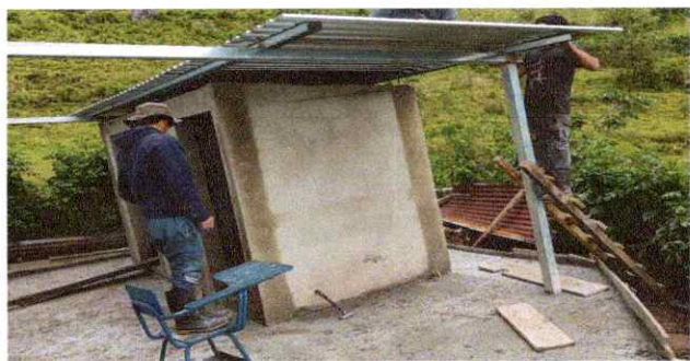
Foto 1: Sustitución de lámina, por lamina troquela aluzinc calibre 26
