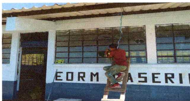
Foto 5: Sustitución de vidrios
