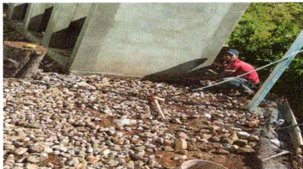
Foto 7: Sustitución de piso de torta de concreto
