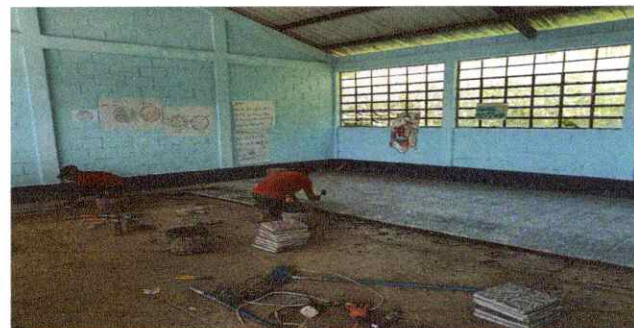
Foto 6: Sustitución de piso de granito
