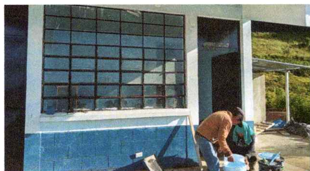
Foto 11: Pintura en muros exteriores e interiores
