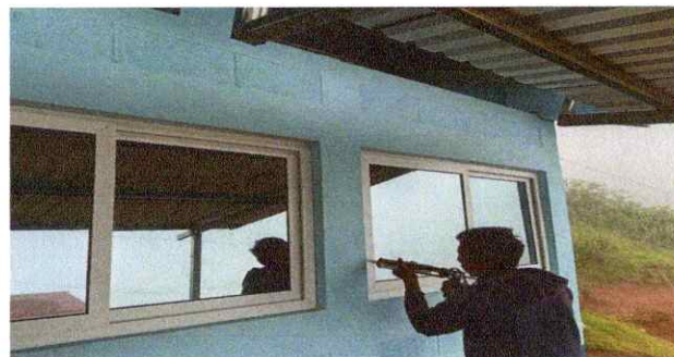
Foto 4: Sustitución de ventanas de madera por PVC mas vidrio
