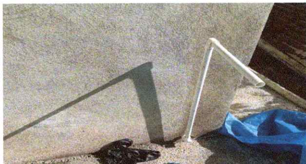
Foto 13: Sustitución de tubería línea principal.
