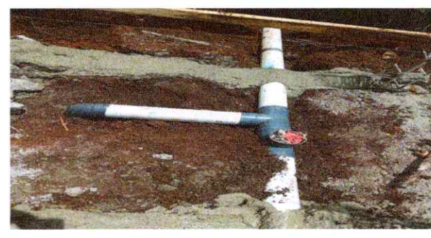
Foto 12: Sustitución de tubería línea principal aguas negras
