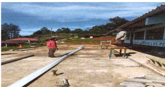
Foto 10: Sustitución de canal de metal por pvc
