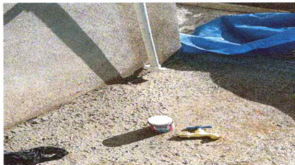
16. Sustitución de Grifo
