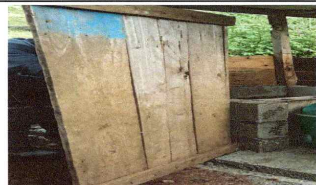
Foto 3: Sustrucción de puerta de 90 centímetros de ancho por 190 centímetros de alto
