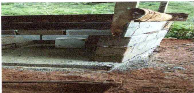
Foto 7: Sustrución de piso de torta de concreto
