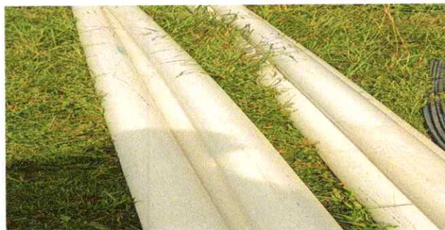
Foto 12: Sustrución de tubería línea principal de aguas negras
