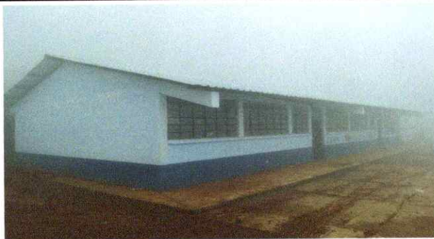
Foto 11: Pintura en muros exteriores e interiores
