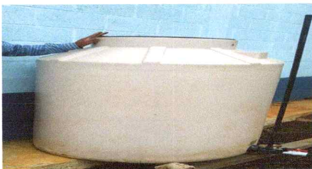
15. Sustitución de depósito de agua 1700L
