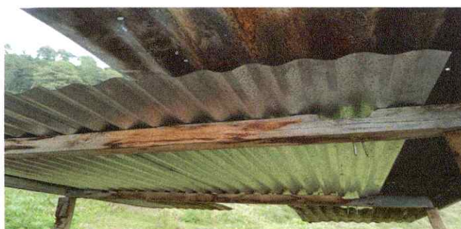
Foto 1: Sustrucción de lámina, por lamina troquela aluzinc calibre 26
