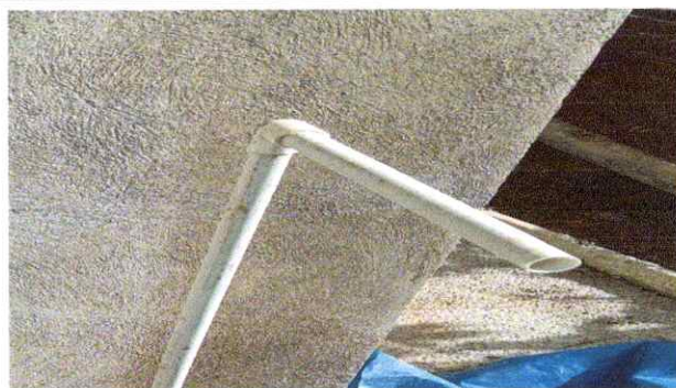
16. sustitución de Grifo
