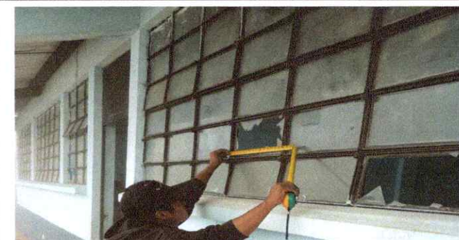
Foto 5: Sustrucción de vidrios
