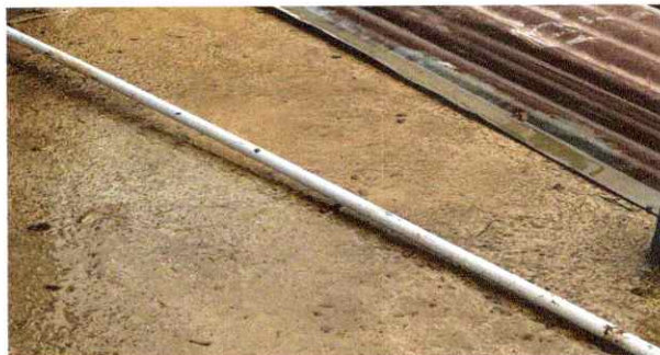
Foto 13: Sustitución de tubería línea principal
