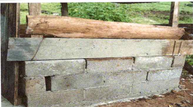
Foto 9: Repello en muro
