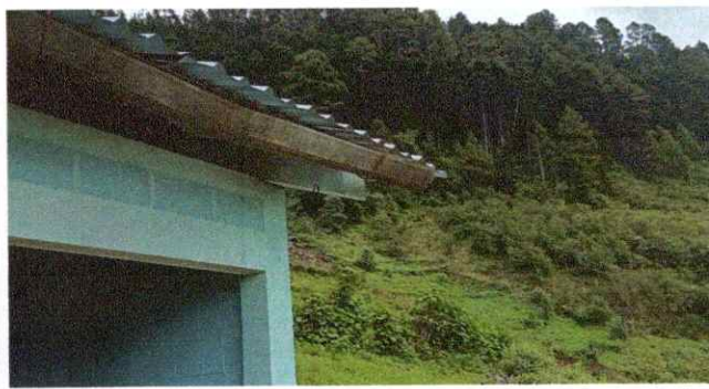
Foto 10: Sustrución de canal de metal por pvc
