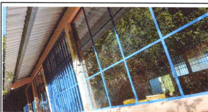
Foto 6: Sustitución de vidrios
