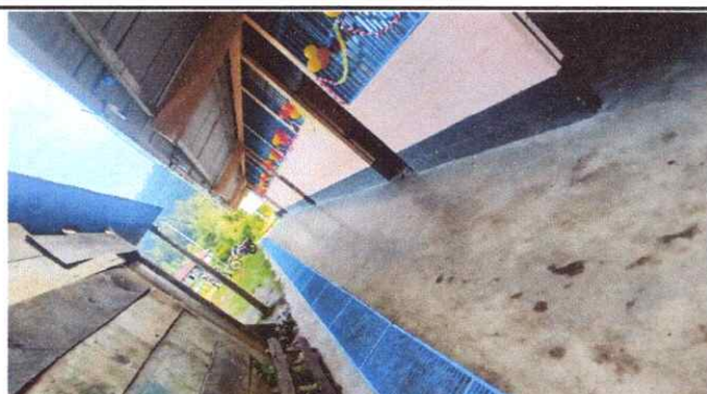
Foto 5: Reparación de cunetas de concreto más reja de metal para bajada de agua pluvial.
