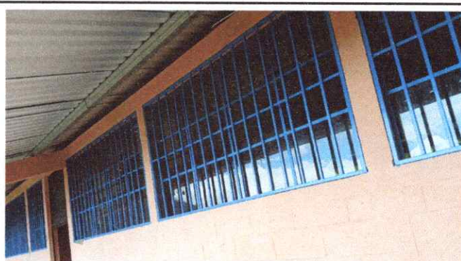
Foto 2: Sustitución de balcones de metal.
