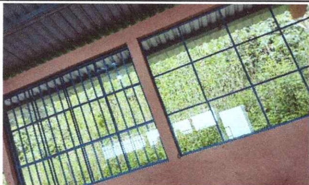
Foto1: Sustitución de estructura de metal de ventana
