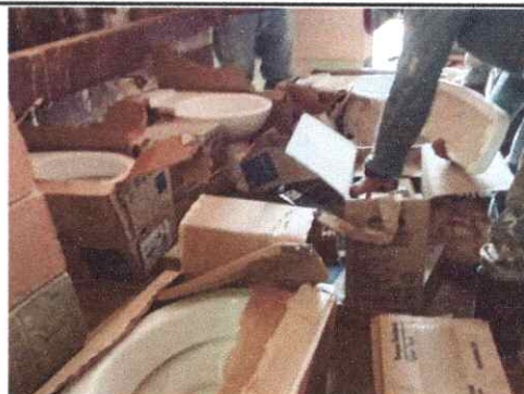
Foto 4: Sustitución de inodoros.
