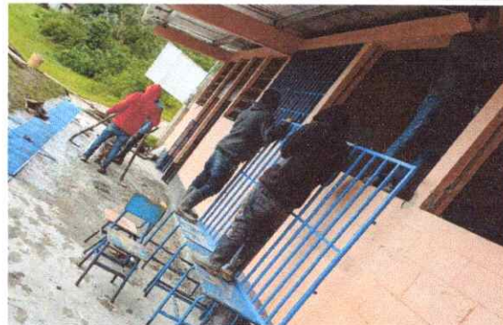
Foto 2: Sustitución de balcones de metal.
