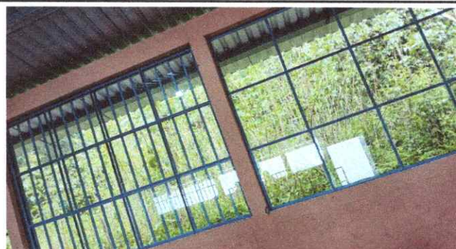
Foto 6: Sustitución de vidrios
