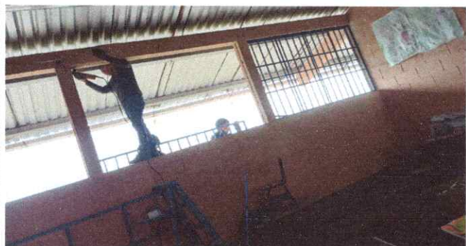
Foto 1: Sustitución de estructura de metal de ventana
