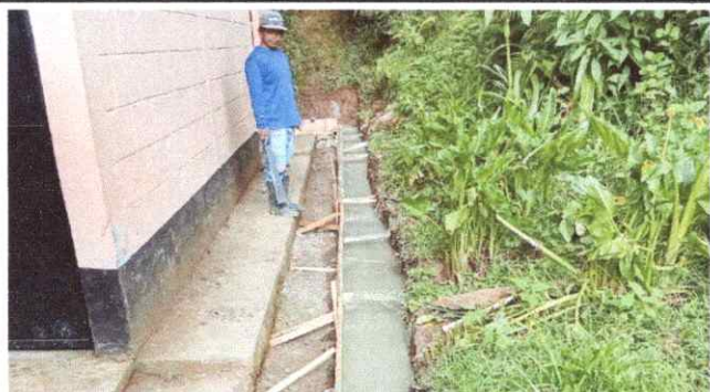
Foto 5: Reparación de cunetas de concreto
