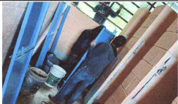
Foto 3: Sustitución de puertas (60 cm. X 150 cm.)
