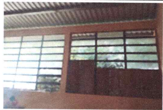
Foto 6: Sustitución de vidrios
