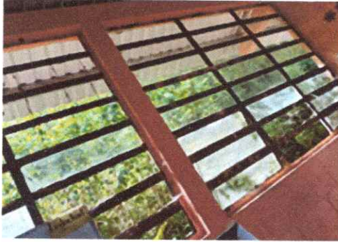
Foto 1: Sustitución de estructura de metal de ventana
