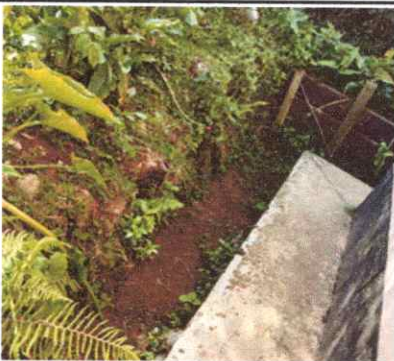
Foto 5: Reparación de cunetas de concreto
