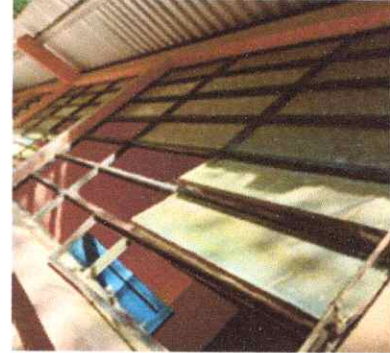
Foto 2: Sustitución de balcones de metal.
