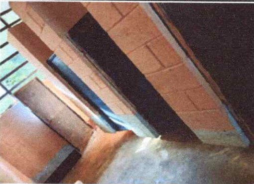
Foto 3: Sustitución de puertas (60 cm. X 150 cm.)
