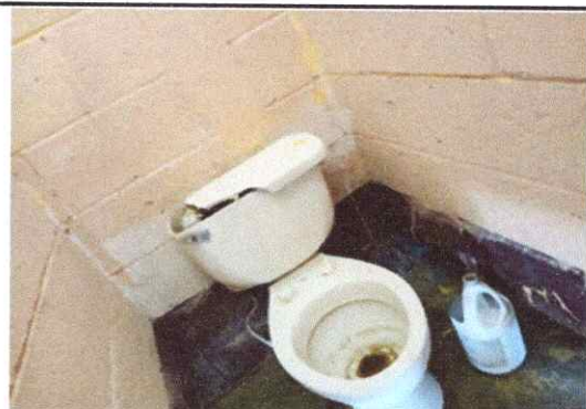
Foto 4: Sustitución de inodoros.
