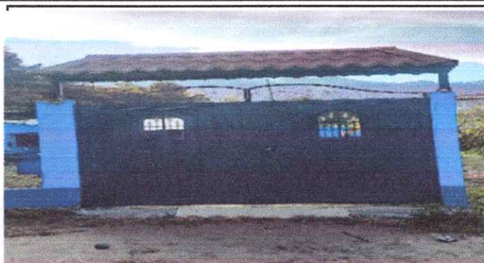
Foto 2: Finalización de portón de metal con techo incluido
