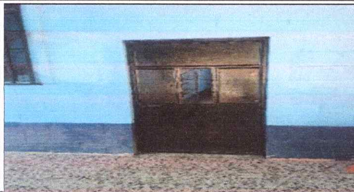
Foto 1: Finalización de chapa de metal.
