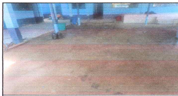
Foto 6: Finalización de piso de torta de cemento.
