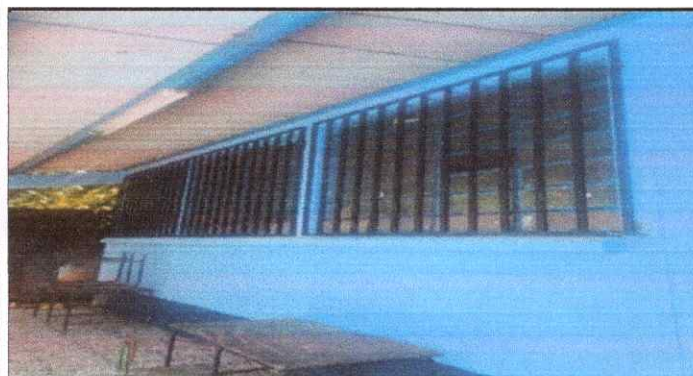
Foto 3: Finalización de valcones de metal.
