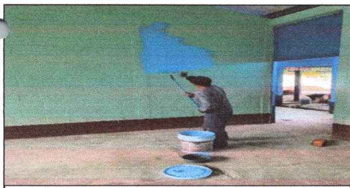
Foto 5: Pintura en muros exteriores e interiores.
