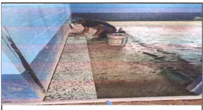
Foto 4: Sustitución de piso de granito .
