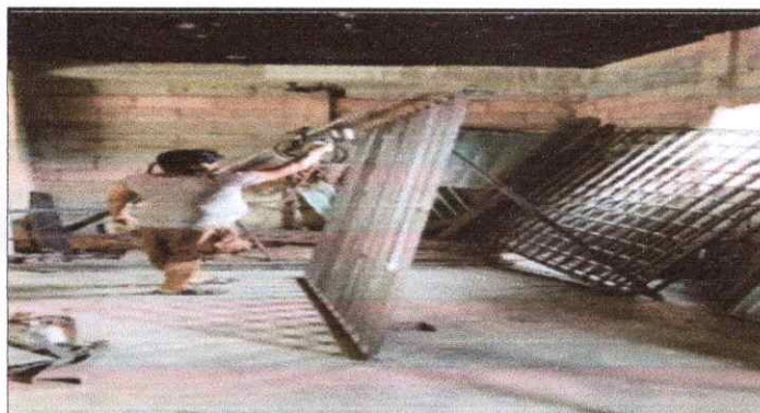
Foto 3: Sustitución de valcones de metal por valcones de metal.
