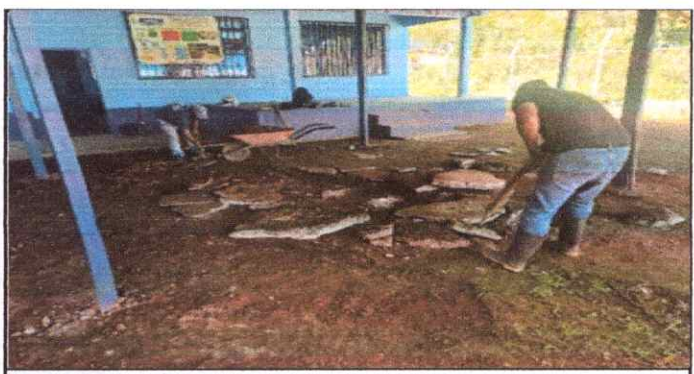
Foto 6: Sustitución de piso de torta de cemento.
