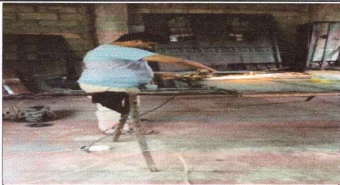
Foto 2: Sustitución de portón de mdetal por portón de metal
