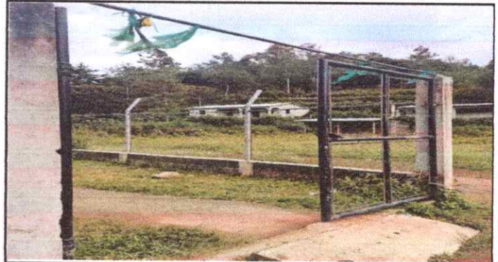
Foto 2: Sustitución de portón de mdetal por portón de metal
