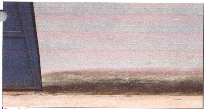
Foto 5: Pintura en muros exteriores e interiores.
