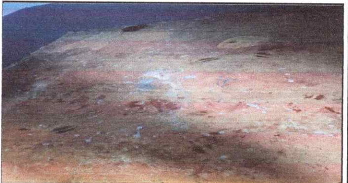
Foto 4: Sustitución de piso de granito .
