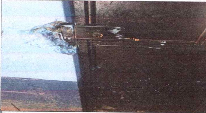
Foto 1: Sustitución de chapa de metal por chapa de metal).
