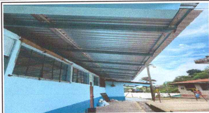
Foto No. 1: terminando colocación de las láminas en el techo.
