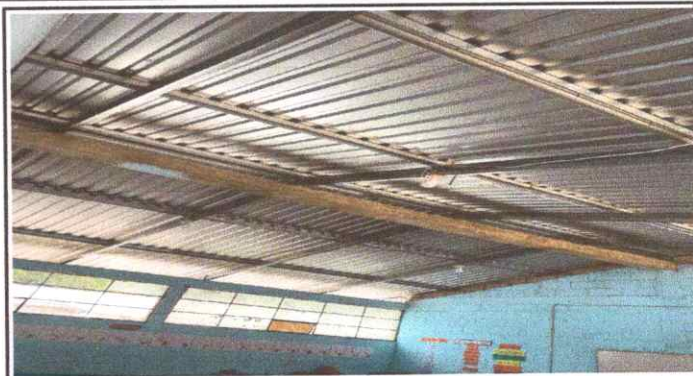
Foto No. 2: terminación de las costaneras en el techo.
