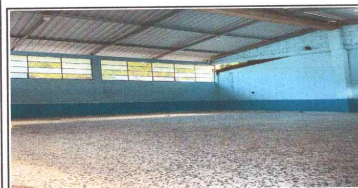
Foto No. 5: terminación del piso en el aula.
