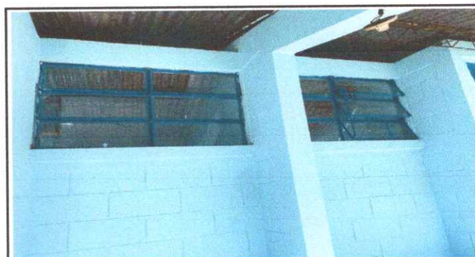
Foto No. 4: terminación de los vidrios en las ventanas.
