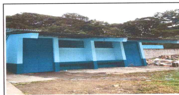
Foto No. 6: terminación pintada de paredes en el baño.
