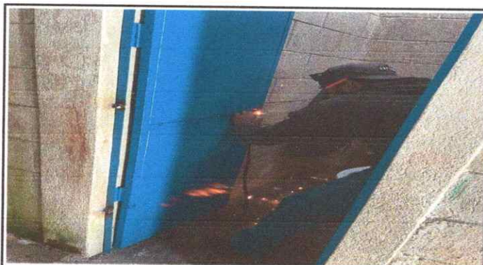
Foto No. 3: colocando puerta en la entrada del baño.
