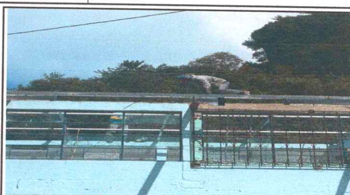
Foto No. 2: colocando costanera en el techo.
