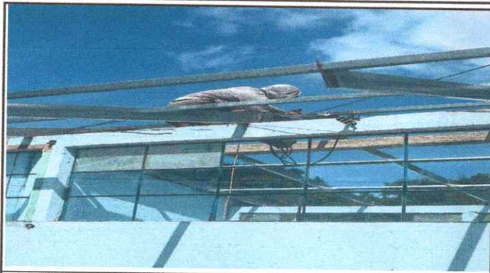
Foto No. 1: colocando láminas en el techo
