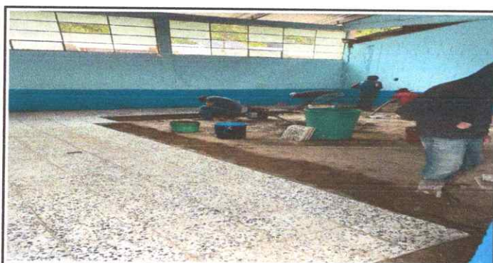
Foto No. 5: colocando piso en el aula.
