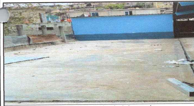
Foto 5: Terminando piso de torta en el patio de la escuela.
