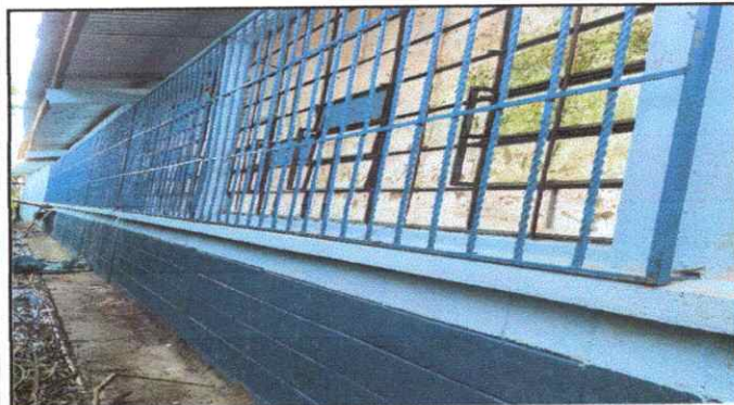
Foto 3: Colocando balcones de metal en la ventana.
