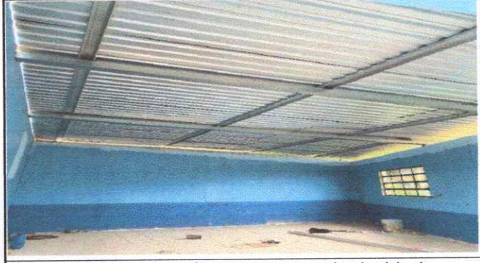
Foto 2: Terminando colocación de costaneras en el techo del aula.
