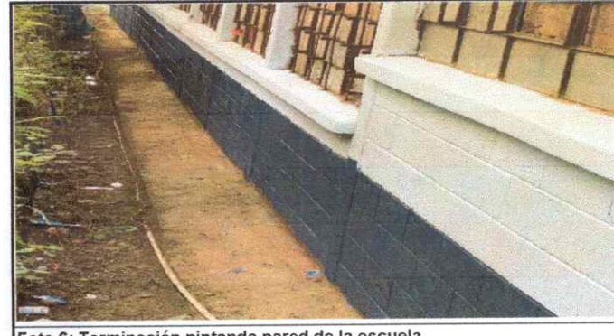
Foto 6: Terminación pintada pared de la escuela.
