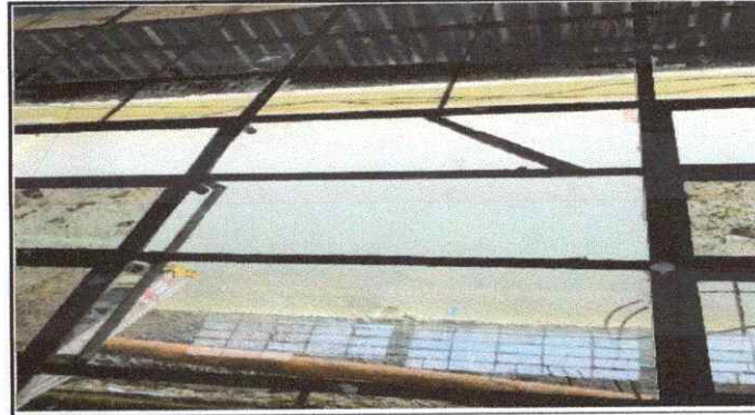
Foto 4: Terminando colocación de vidrios en la ventana.
