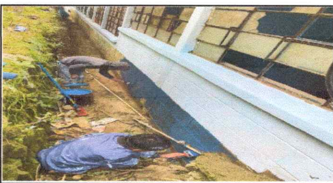
Foto 6: Pintando pared de la escuela.
