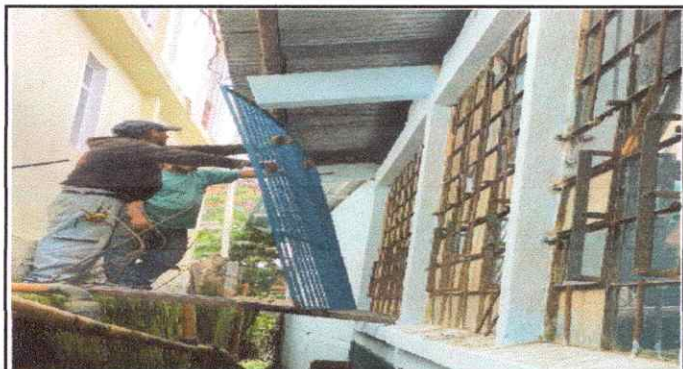
Foto 3: Colocando balcones de metal en la ventana.
