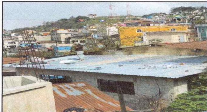
Foto 1: Colocando láminas en el techo del aula.
