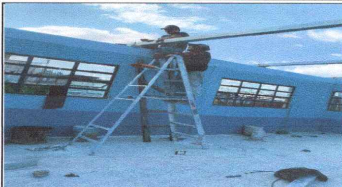
Foto 2: Colocando costanera de sustitución de láminas en el techo del aula.
