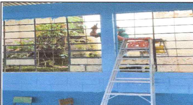
Foto 4: Colocando vidrios en la ventana.
