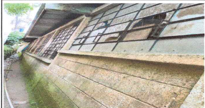
Foto 4: Sustitución de vidrios en mal estado
