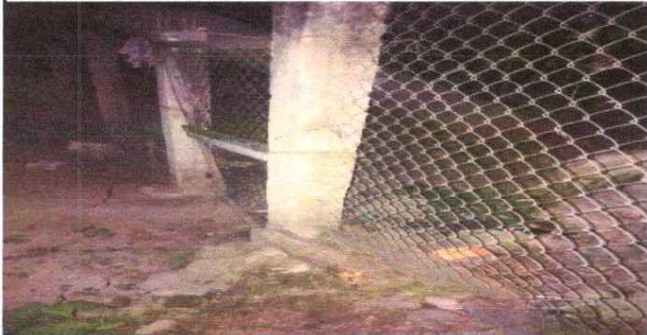
Foto1: Reparación de muro perimetral
