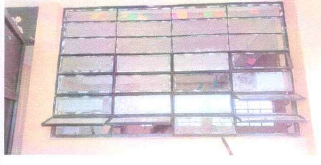
Foto 2: Mejoramiento de balcones de metal
