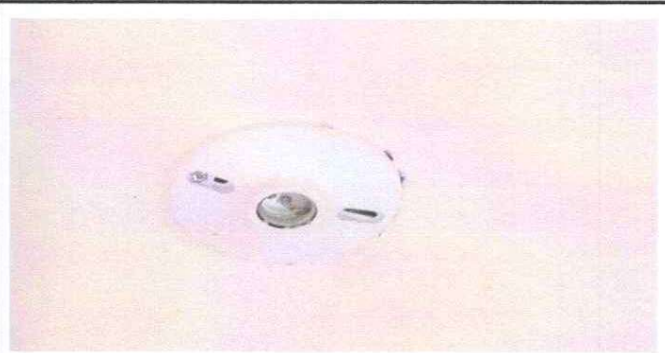
Foto 4: Sustitución de lámparas LED
