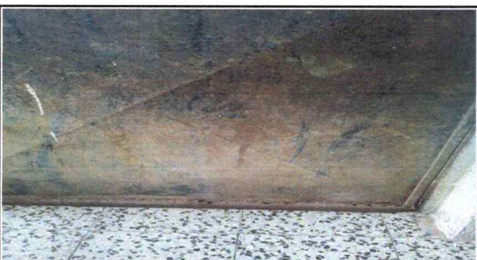
Foto 3: PUERTAS DE METAL
