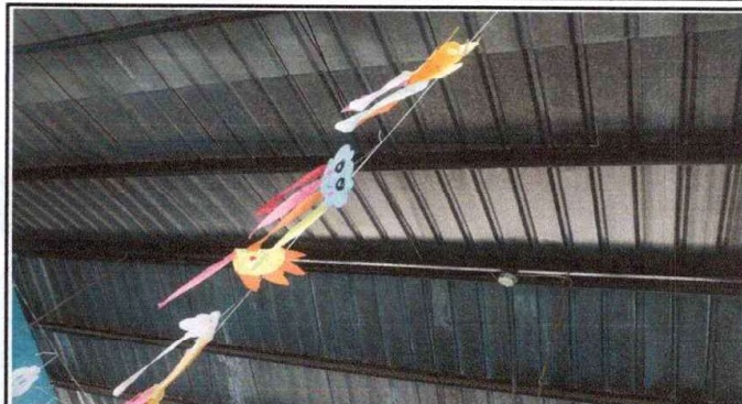
Foto 2: ESTRUCTURA DE TECHO
