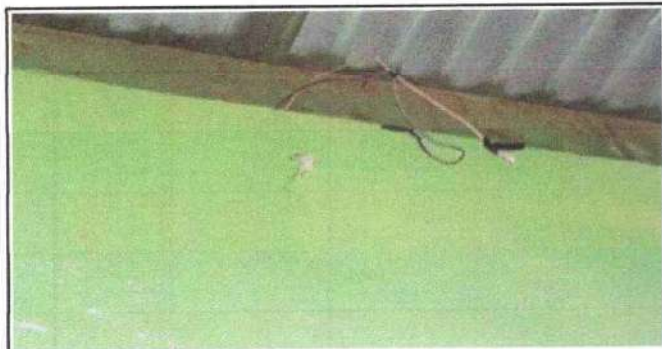
Foto 5: Reparación de cableado eléctrico
