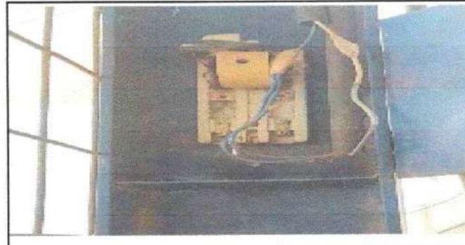
Foto 6: Sustitución de tablero de flipones
