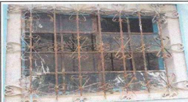
Foto 2: Sustitución de ventanas
