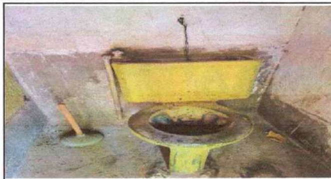
Foto 2: Sustitución de inodoro y sus accesorios
