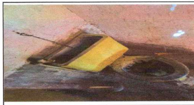
Foto 6: Sustitución de piso de granito
