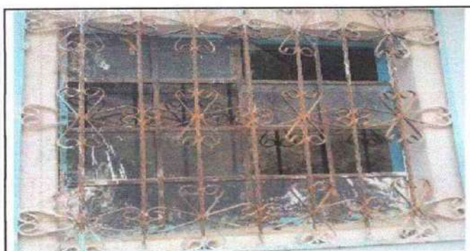
Foto 3: Sustitución de balcones de metal
