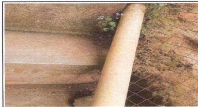
Foto 4: Mejoramiento de tubería PVC lineal de aguas negras
