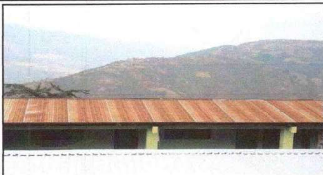
Foto 1: Cubierta de lámina
