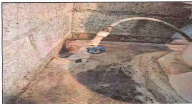
Foto 3: Sustitución de llave de paso
