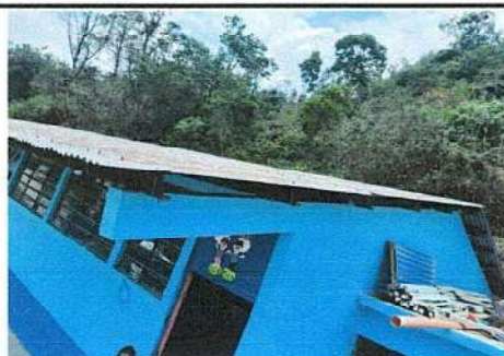
Foto 5: ventanales sin balcones
