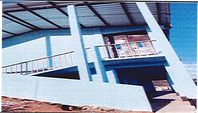
Foto 3: pintura exterior e interior
