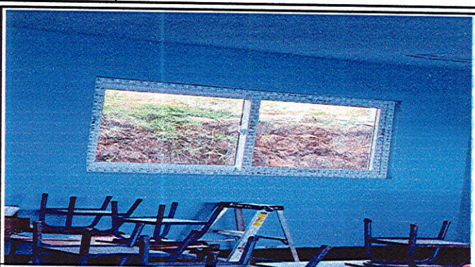
Foto 2: sustitucion de ventanas
