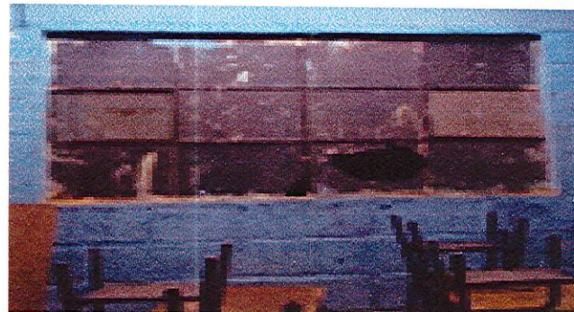
Foto 2: sustitucion de ventanas
