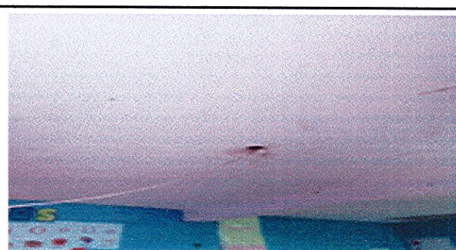
Foto 5: reparacion de energia electrica
