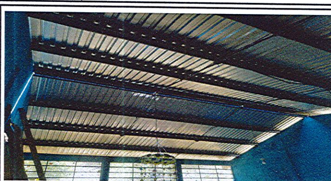
Foto 2: ESTRUCTURA DE TECHO
