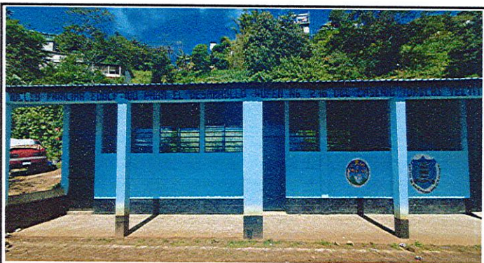
Foto 3: PUERTAS DE METAL
