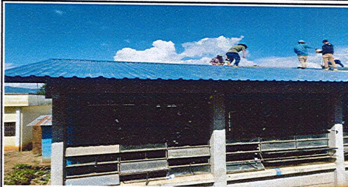
Foto1: CUBIERTA DE LAMINA
