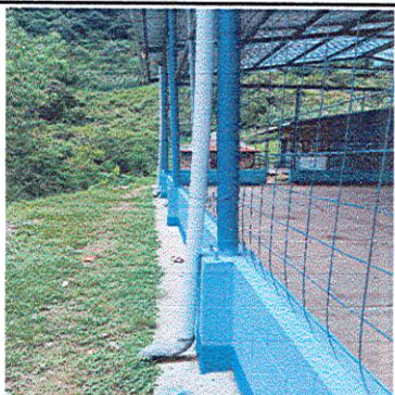
Foto 3: Se compusieron las bajadas de aguas Fluviales
