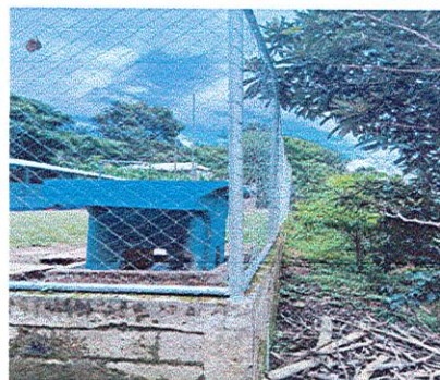
Foto 4: Se mejoro la circulacion con maya y tubos galvanizados.
