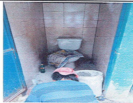
Foto 2: Reemplazando taza sanitaria
