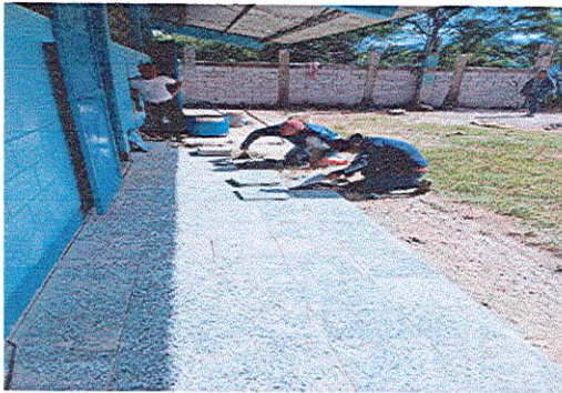
Foto 1: Se estaba mejorando el piso del corredor de la escuela
