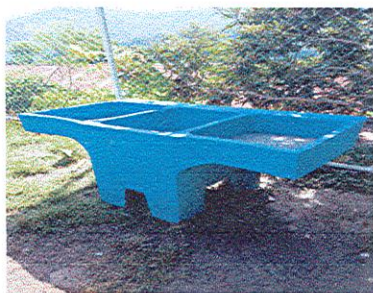
Foto 5: pila de concreto nuevas se estaban instalando.
