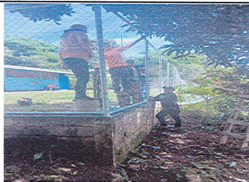
Foto 4: Se estaban colocando malla para la circulacion
