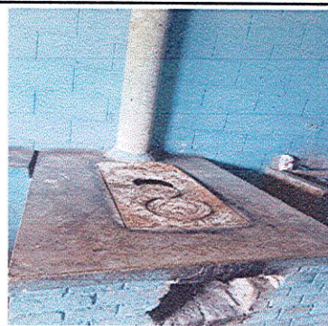
Foto 6: Sustitución de plancha y mejoramiento de cocina.
