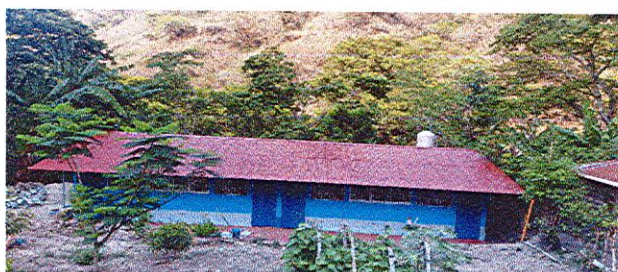
Foto No. 3 Pintura en exterior
