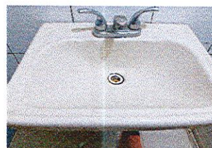
Foto No. 6 Lavamanos nuevo
