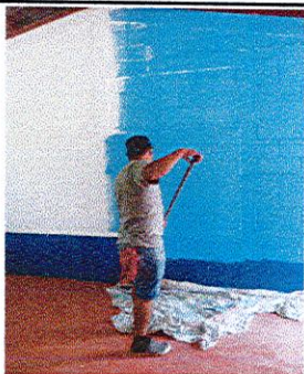
Foto No. 7 Pintando muros internos
