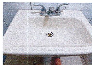
Foto No. 6 Cambio de lavamanos
