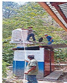
Foto No. 8 Instalación del Rotoplas
