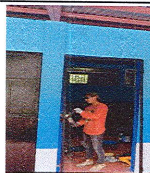
Foto No. 4 Cambio de puertas
