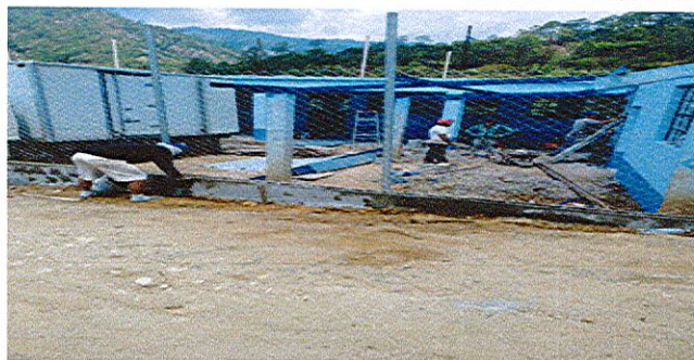
Foto1: reparacion de muro perimetral y maya calbанизada
