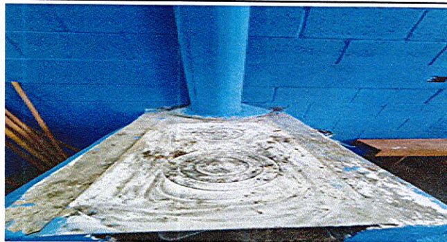
Foto 2: Sustitución de planca de fogon y tubos de chimenea
