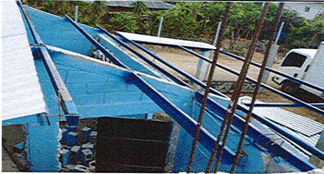
Foto 1: Sustrucción de lámina troquelada aluzinc calobre 26
