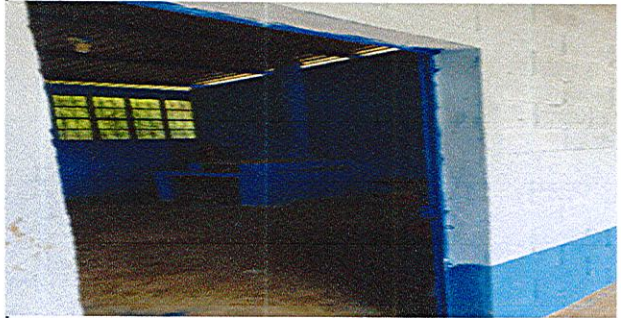
Foto 4: Sustrucciones de puertas metalicas
