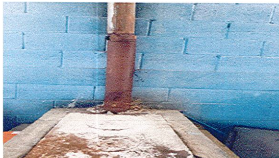
Foto 2: Sustitución de planca de fogon y tubos de chimenea
