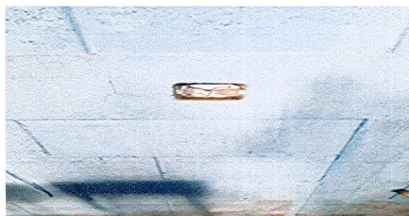
Foto 3: sustitucion de toma corriente
