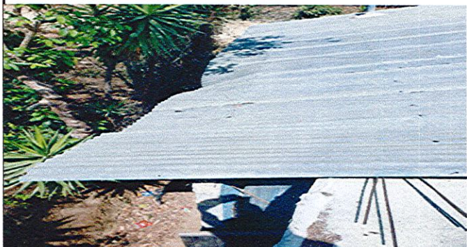
Foto 1: Sustrucción de lámina troquelada aluzinc calobre 26
