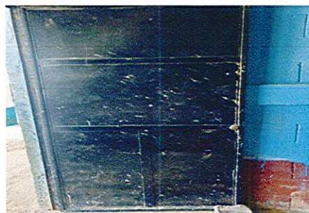
Foto 4: Sustrucciones de puertas metálicas
