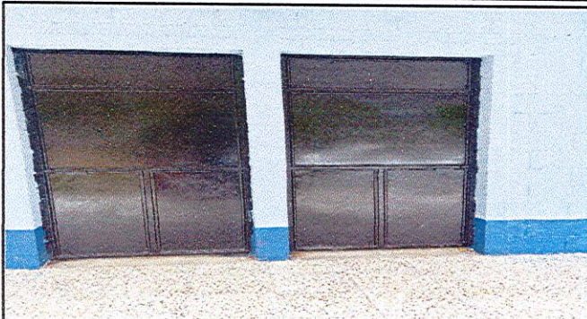
Foto 1: MANTENIMIENTO, LIJADO Y PINTURA DE PUERTAS
