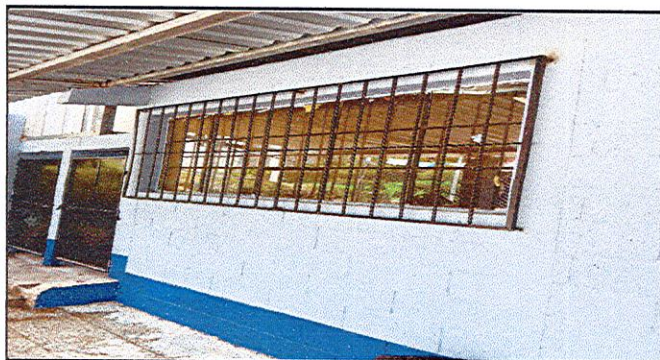
Foto 9: COLOCACIÓN DE BALCÓN FINALIZADO
