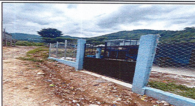
Foto 2: COLOCACIÓN DE PORTÓN DE METAL FINALIZADO
