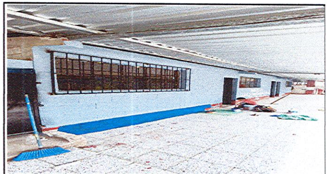
Foto 8: APLICACIÓN DE PINTURA A MUROS EXTERIORES
