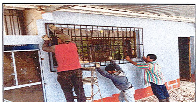
Foto 12: COLOCACIÓN DE BALCÓN DE METAL
