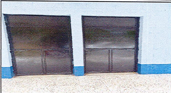
Foto 1: MANTENIMIENTO, LIJADO Y PINTURA DE PUERTAS
