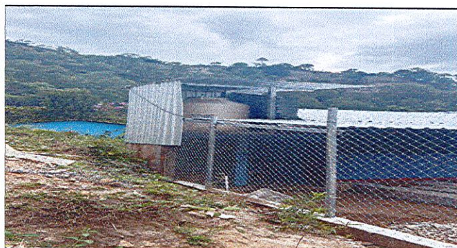
Foto 11: INSTALACIÓN DE DEPÓSITO DE AGUA (TINACO) FINALIZADA
