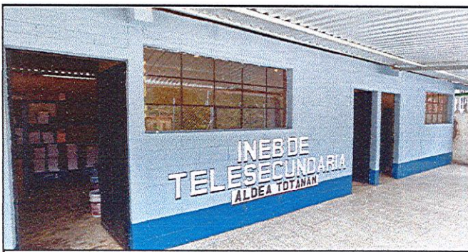
Foto 5: PINTURA EN EXTERIORES
