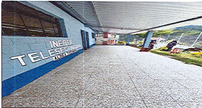
Foto 6: COLOCACIÓN DE PISO DE GRANITO
