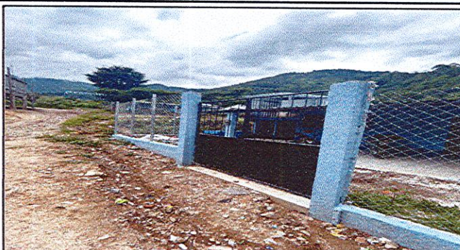
Foto 2: COLOCACIÓN DE PORTÓN DE METAL FINALIZADO
