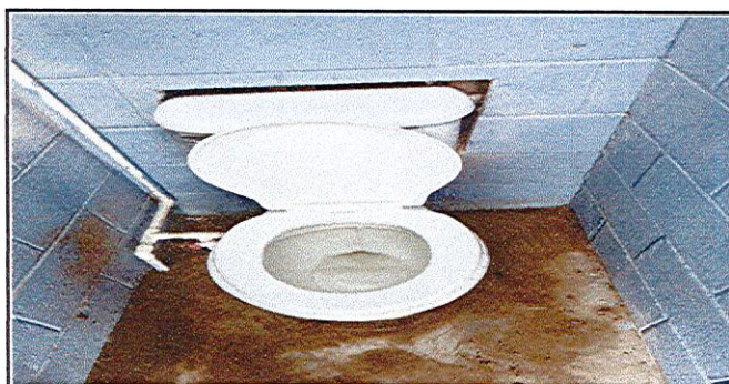
Foto 11: MEJORAMIENTO DE SERVICIOS SANITARIOS
