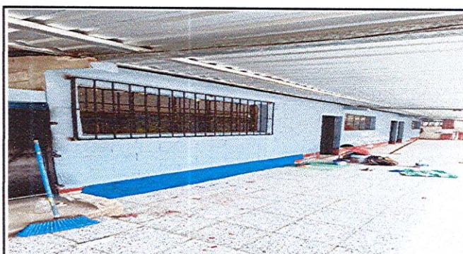
Foto 8: APLICACIÓN DE PINTURA A MUROS EXTERIORES
