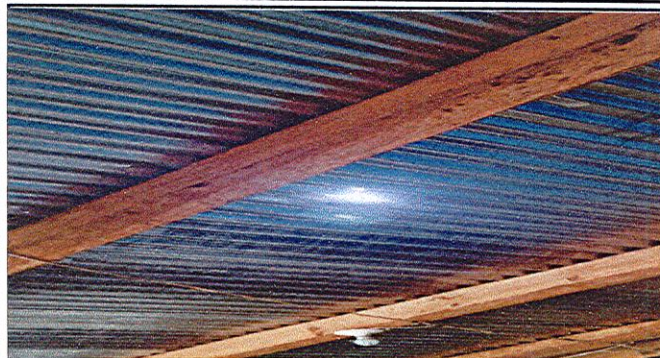
Foto1: CAMBIO DE LÁMINA
