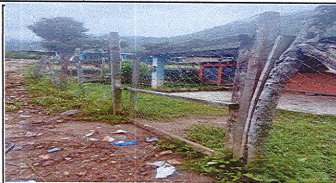
Foto 2: INSTALACIÓN DE PORTÓN
