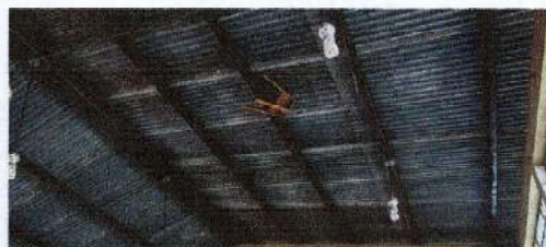
Foto No. 8: Sustitucion de estructura de maderera por estructura de metal
