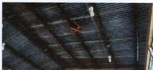
Foto No. 9: Sustitucion de focos normales por focos LED
