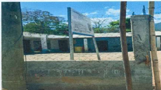
Foto 1: reparación de muro perimetral y maya calbanizada
