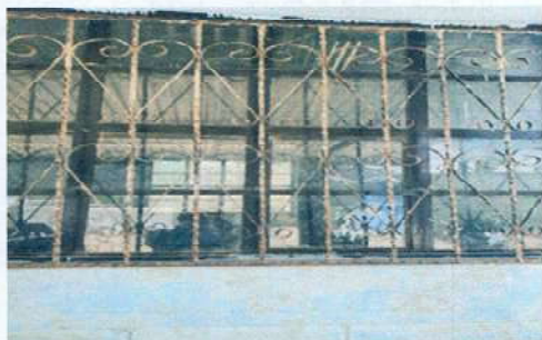
Foto 5: Sustitución de balcones de metal
