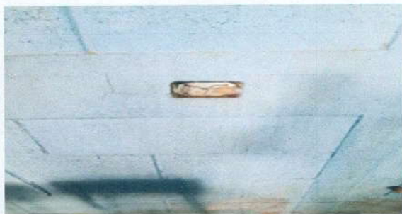
Foto 3: sustitución de toma corriente
