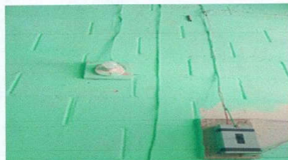
Foto 4: Sustitución de malla galvanizada
