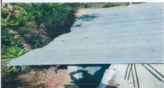
Foto 1: Sustitución de lámina troquelada aluzinc calobre 26
