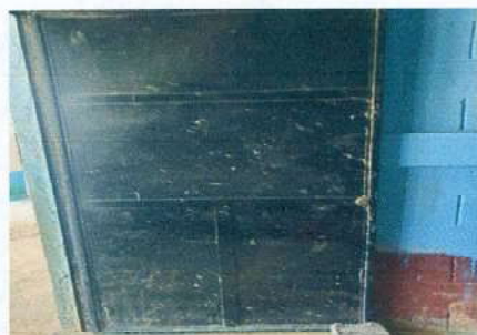
Foto 4: Sustituciones de puertas metálicas
