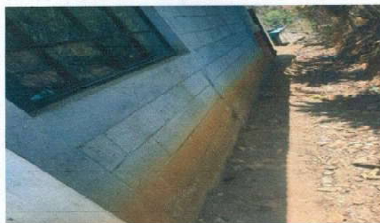
Foto 6: Sustitución de pintura
