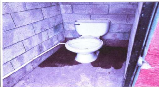
Foto 11: cambio de tazas de servicios sanitarios
