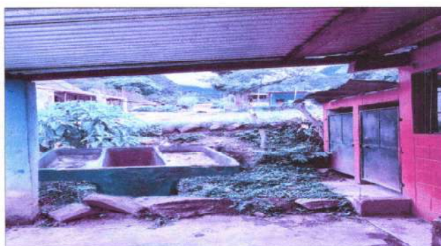
Foto 8: cambio de depósito de agua (pila)
