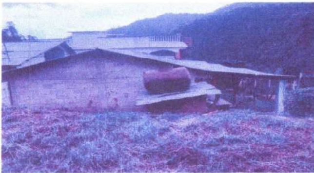
Foto 3: cambio de depósito de agua (Tinaco)
