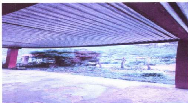
Foto 7: cambio de costaneras de madera pandeadas por estructura de metal
