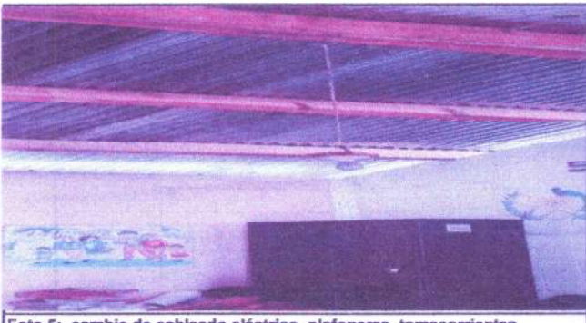
Foto 5: cambio de cableado eléctrico, plafoneras, tomacorrientes
