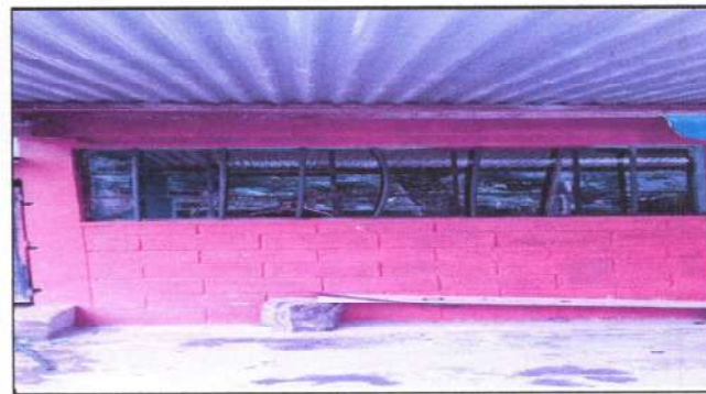
Foto 12: colocación de balcón de metal en ventanas
