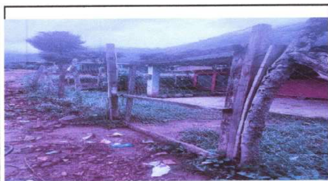
Foto 9: colocación de portón de ingreso
