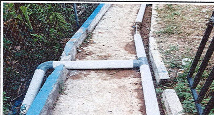
Foto 1: Se sustituyó la tubería PVC línea principal aguas negras
