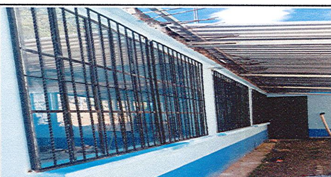
Foto 5: Se mejoraron los balcones de metal en ventana en ambos lados.
