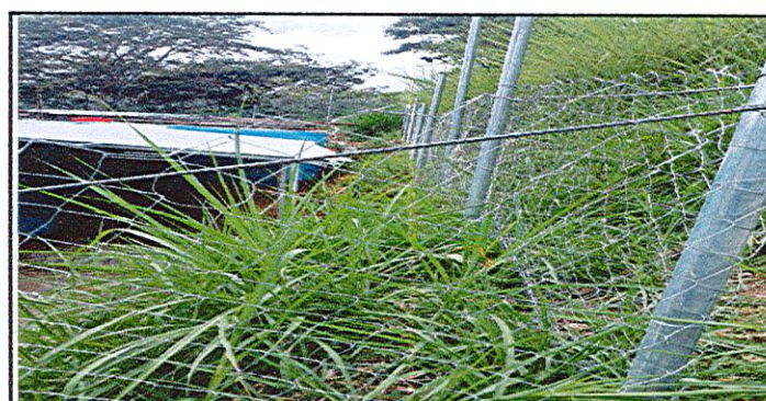
Foto 6: Se repara el muro perimetral de block con tubo hg y malla galvanizada, soleras intermedias y columnas.
