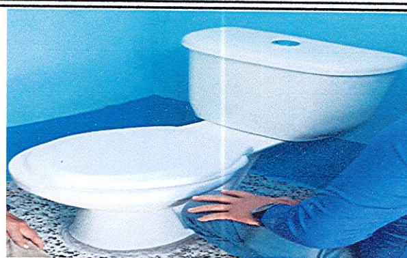
Foto 2: Se sustituyó el inodoro.
